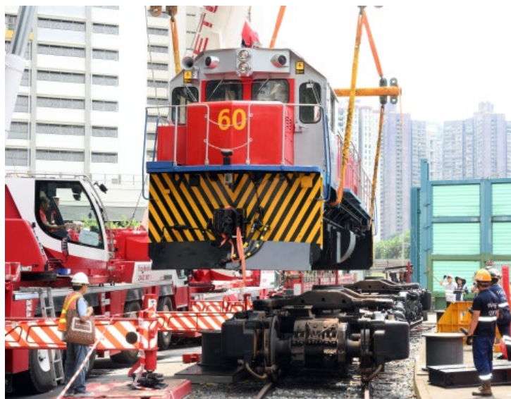
60 號機車正進行吊運工作，2023 年。 Lifting operation of No. 60, 2023. (香港文化博物館相片 Photo of the Hong Kong Heritage Museum)
