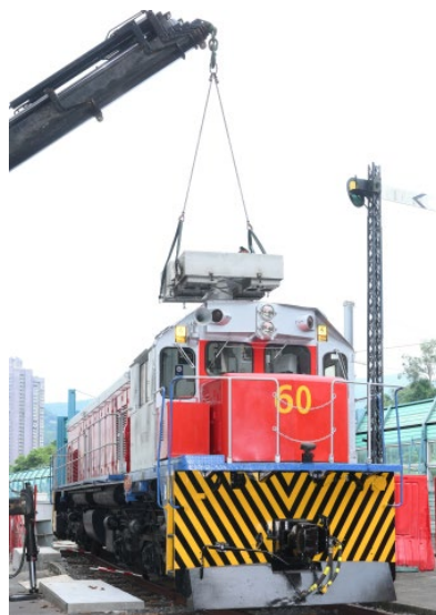
60 號機車正進行最後組裝，2023 年。 No. 60 under final installation work, 2023. (香港文化博物館相片 Photo of the Hong Kong Heritage Museum)
